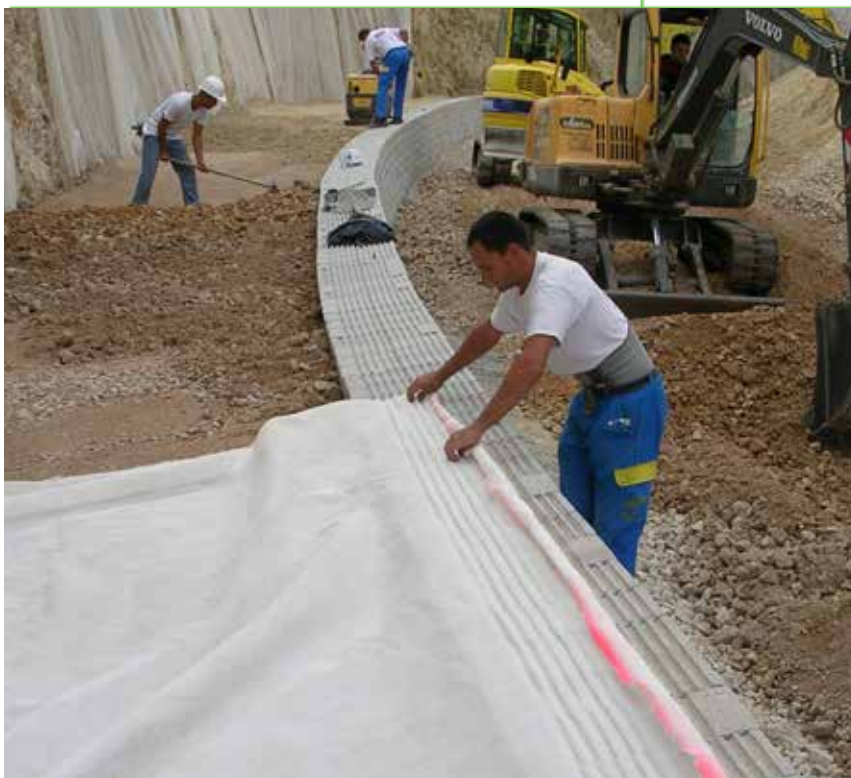
Renforcement et stabilisation de remblais et murs
