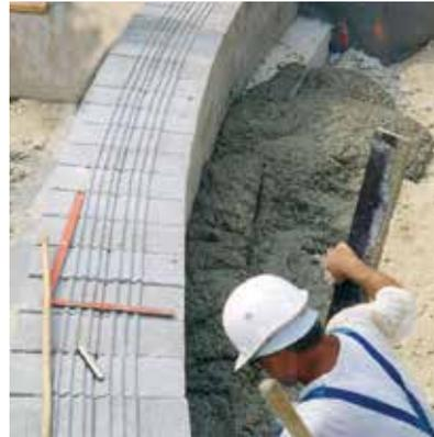
Les temps de pose varient selon l'importance du chantier et la hauteur de l'ouvrage. Dans de très bonnes conditions, une équipe de 4, matériaux à pied d'oeuvre, peut assembler jusqu'à 35 m<sup>2</sup> par journée de 8 heures.
